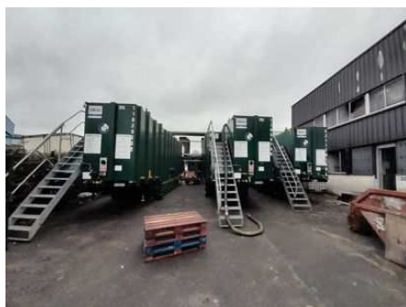
Figure 3: Photo du 04 janvier 2023 - tanks de stockage (4x70 m 3 ) des eaux pompées
