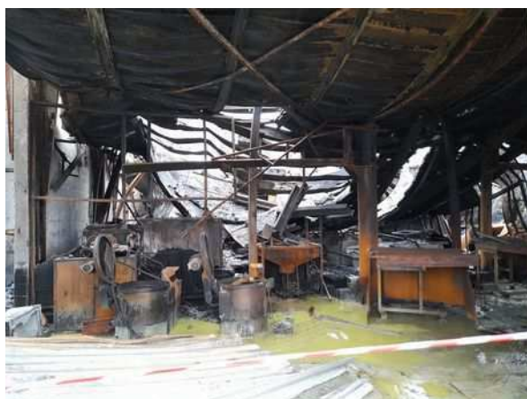
Figure 4: Photo du 04 janvier 2023 - toiture effondrée sur les baignoires de traitement
